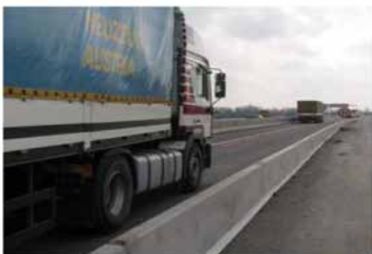
Skydd av en arbetsplats – kapacitetsklass H1
