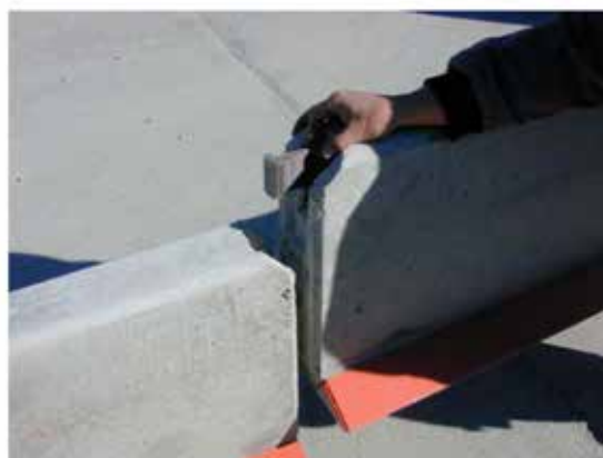
Elementet sänks ned och sätts ihop med den patenterade kopplingen
