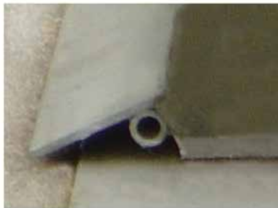
Vinkeljärn med stålkärna för spännbulten
